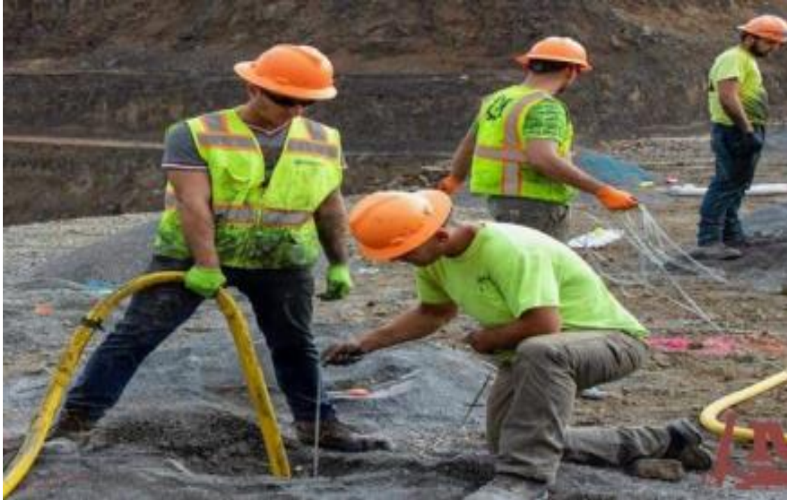
FIG. I, 11, Travaux de tir[17]
