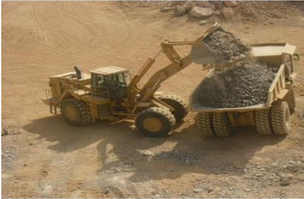
Fig.III.5, Chargeuse entraine de charger le camion (compartiment II).
