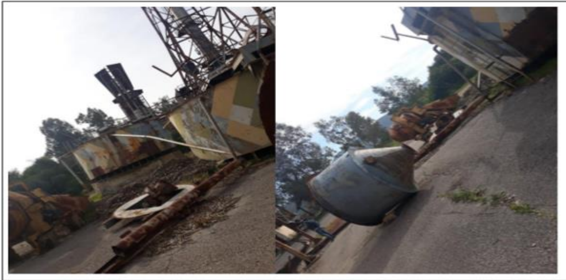
Figure 1.11: Les trémies d'alimentation (Sortie du 22mai 2021).
