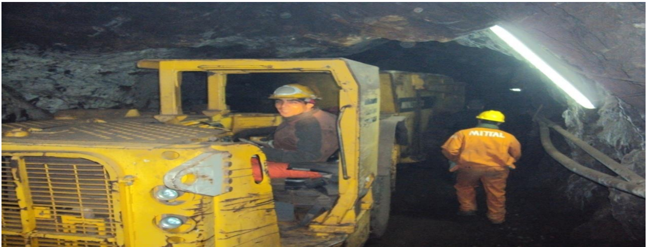
Figure III-2 : Camion dans la mine souterraine
