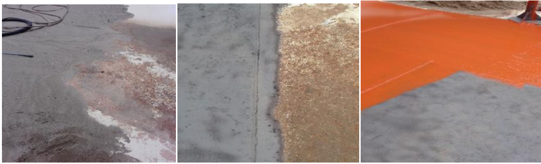
Fig. I.1. Préparation du surface avant de faire la protection
